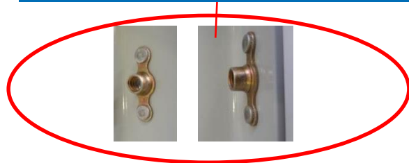
Abgedichtete Erdungspunkte
