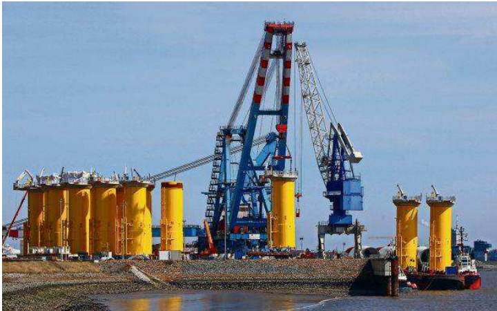
Neben den Fundamentröhren, den sogenannten Monopiles, werden dort auch die Transition-Pieces hergestellt. Diese bilden die Verbindung zwischen Monopile und der eigentlichen Windkraftanlage. Foto: Blumenkamp
