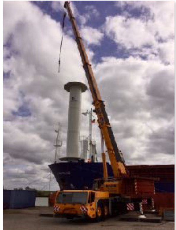
Am Mittwoch, 13. Juni, wurde der Eco-Flettner von einem Kran der Firma Ulferts auf die „Fehn Pollux“ gehoben.
